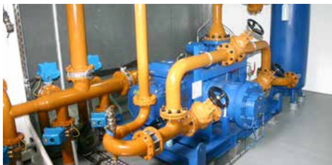
Die Kraftstoffmessanlage kann auch die Masse des Kraftstoffes ermitteln
